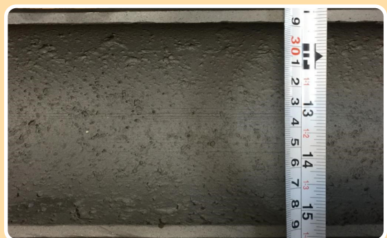
شکل (۲): خوردگی حفره ای زیر رسوب بر روی سطح داخلی لوله
